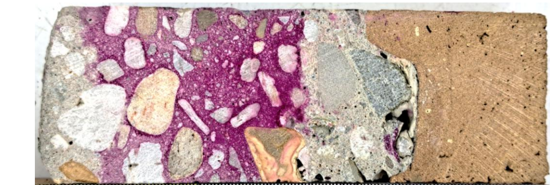
10 Onderwapening in gecarbonateerd beton
